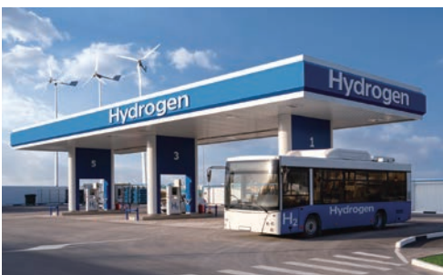
水素ステーション
