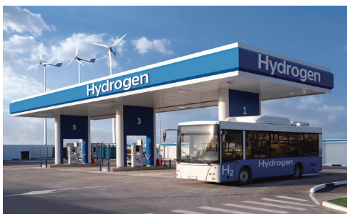
水素ステーション
